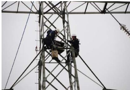
Het ringen van jonge Slechtvalken in de hoogspanning.
