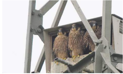
Jonge slechtvalken in de hoogspanningsmast
